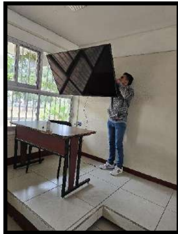
Figura 139. Reparación y mantenimiento de las pantallas ubicadas en las aulas
